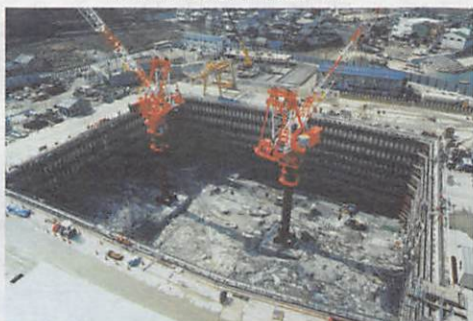
淡路島側アンカレイジ基礎の土留内の掘削
