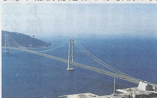
明石海峡大橋全景
