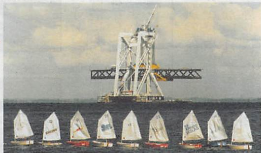
写真3 7000トンの吊級自走式クレーン船によるオレソン橋の桁架設(1996年)
