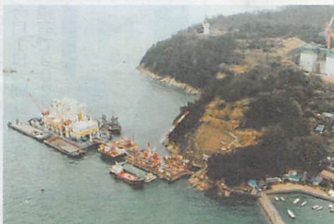
大径粗骨材投入後にモルタル注入工事
