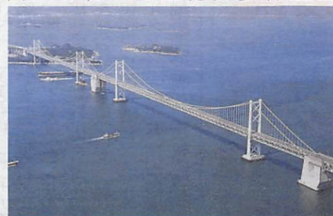
北備讃瀬戸大橋と南備讃瀬戸大橋
