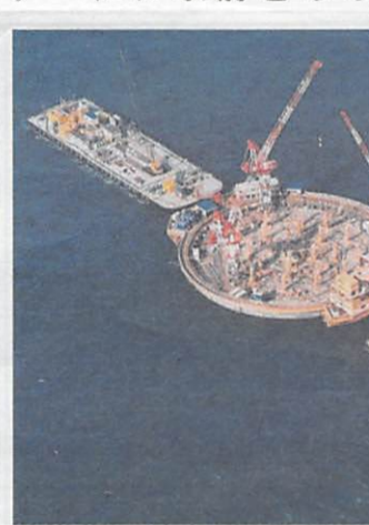
塔基礎の水中不分離性コンクリート打設
