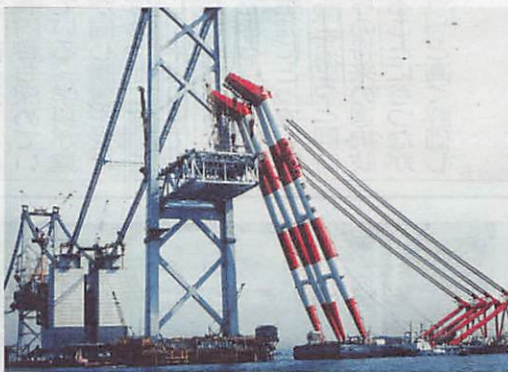
南備讃瀬戸大橋補剛桁の大ブロック架設
