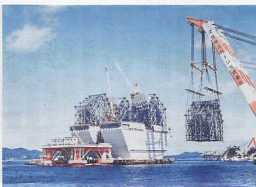
吊橋ケーブルアンカーフレームの大ブロック架設
