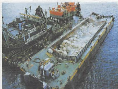
底開バージによる捨石の施工
