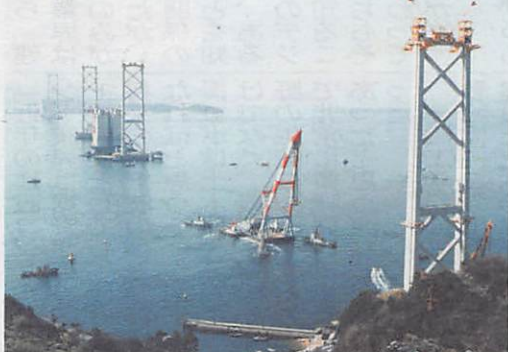
クレーン船によるパイロットロープ渡海
