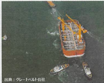
写真2 グレートベルト橋塔基礎ケーソン(35×78m)の曳航(1993年)
