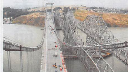
(写真1) トラス橋から吊橋に架け替え工事中のカルキネツ橋 (2003年)
