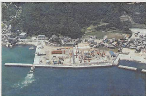
民地と埋立地併用の淡路島側作業基地
