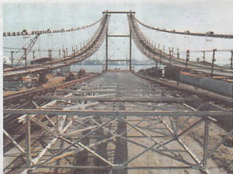
吊橋補剛桁の送り出し実験
